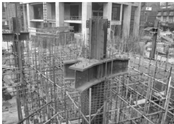
图 16 钢结构柱节点进场吊装就位
