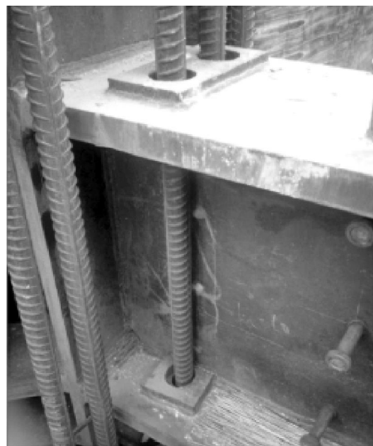
图 17 翼缘开孔加强及柱纵向钢筋穿插
