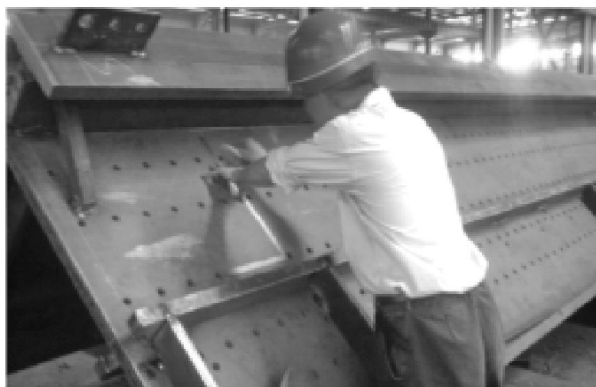
图 14 根据零件图精确放样,采用埋弧自动焊保证构件质量
