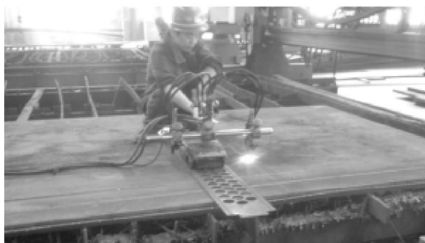
图 13 采用先进数控切割机进行原材加工
