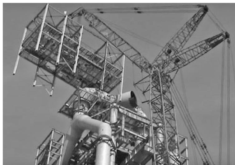
图5 穿梭(框架由一侧向另一侧滑移)
