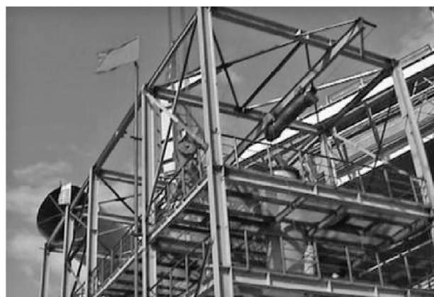
图3 挂钩(钩头低于框架顶部)
