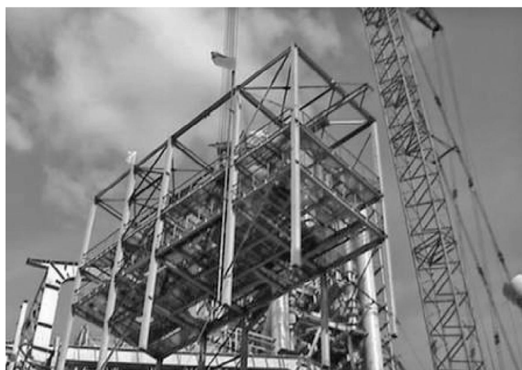
图4 起钩(确保构件稳定平衡)
