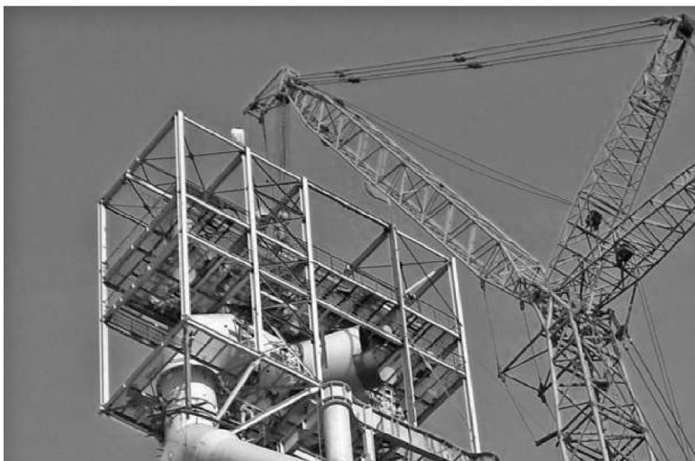
图7 就位松钩(控制所有柱子到位焊接牢固)
